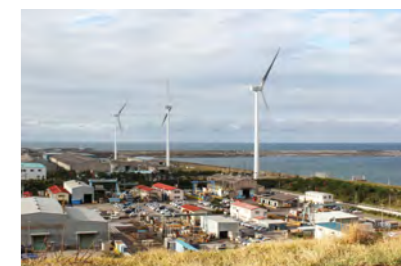
▲不気味な天気。鹿島灘。飛ばされそうな強風の中、風力発電の風車がうなるようにまわっていました（某製鉄所にうかがった合間に撮影）。
