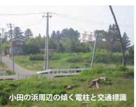
小田の浜周辺の傾く電柱と交通標識
